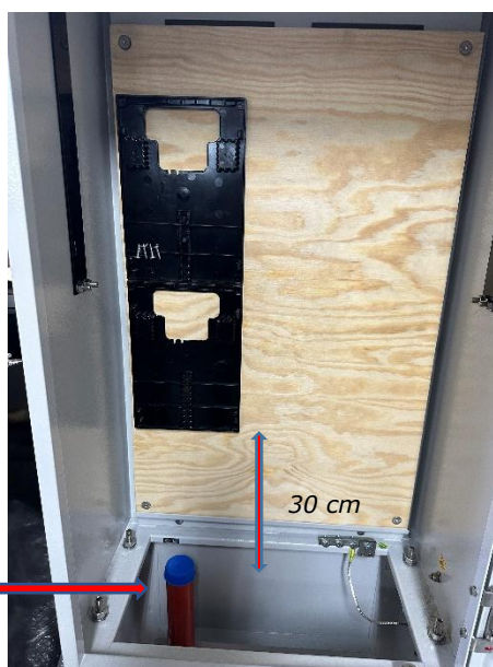
Voorbeeld doorvoerbuis
